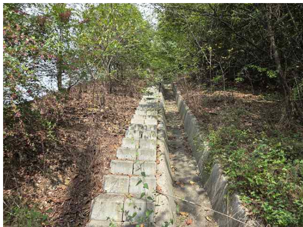
산마루측구, 점검계단 전경
